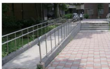
於住宅出入口處設置坡道
