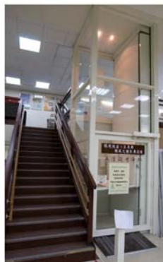
© 攝自內政部多功能輔具資源整合推廣中心 無障礙昇降機
