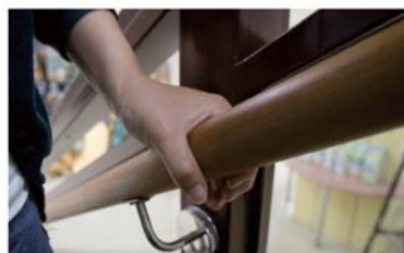
© 攝自內政部多功能輔具資源整合推廣中心 扶手直徑介於2.8-4公分之間
