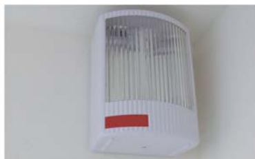
◎ 攝自內政部多功能輔具資源整合推廣中心 緊急照明燈
