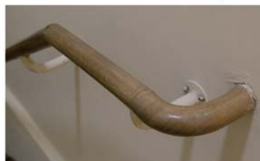
扶手端部固定於牆面上
