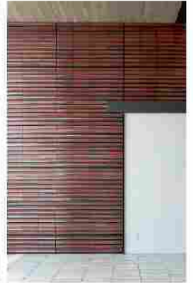
西側腳踏車停放處 近景
