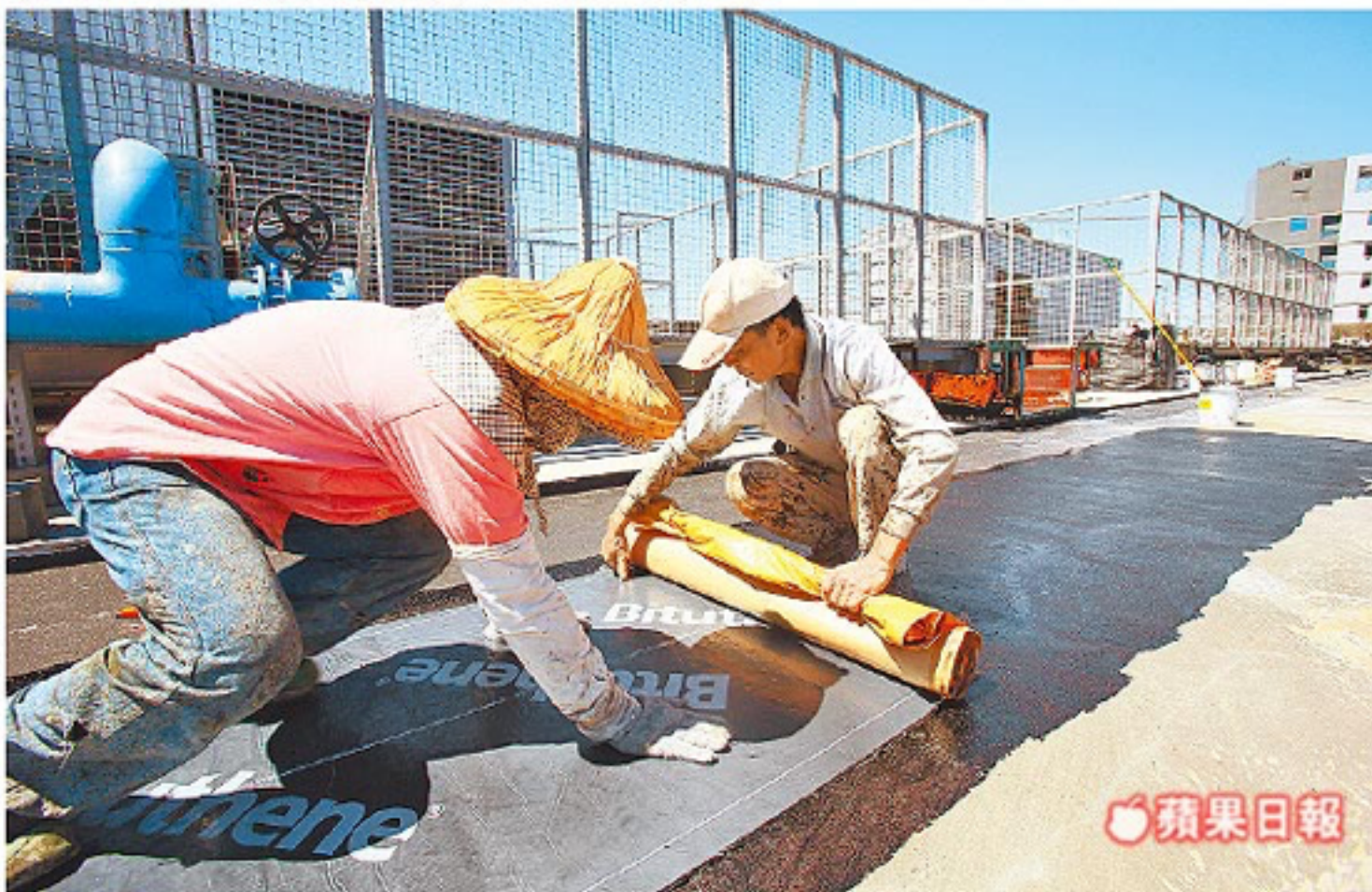
屋頂防水施工
