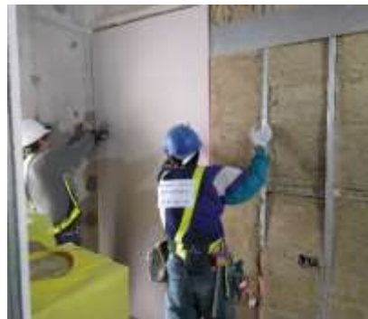
六、填塞岩棉、封板
