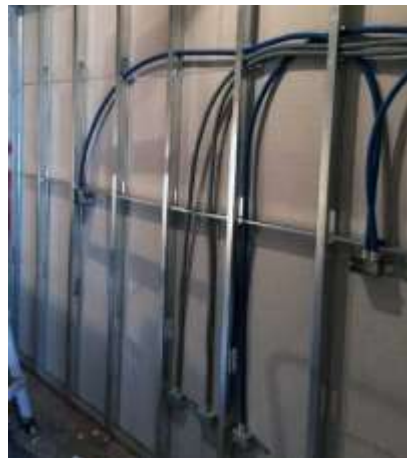
五、機電配管配線(明管)
