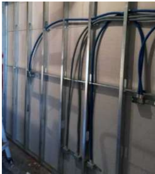
輕隔間牆配管工程
