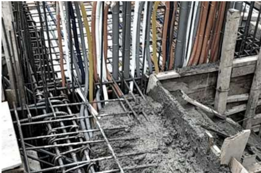
RC牆配管工程
